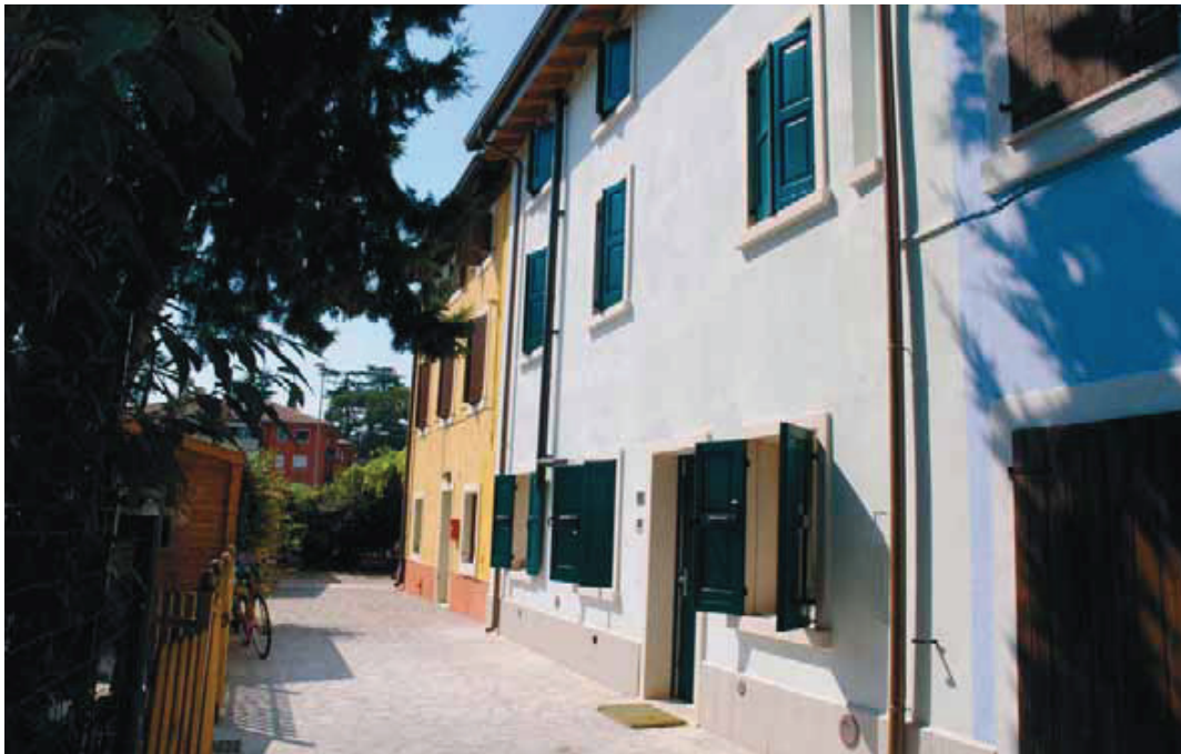
L'edificio a lavori conclusi
