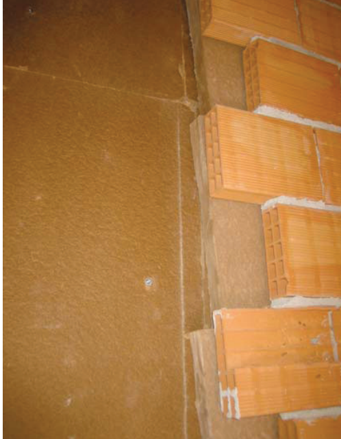
Isolamento della parete fra le unità abitative
